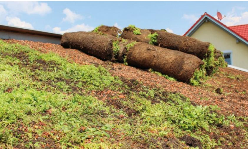
Das Ausrollen der Vegetationsmatten, die nach dem Abladen zuerst am First entlang verteilt wurden, geht sehr zügig. Die obere Sicherung mittels Kabelbinder hat sich bewährt.
