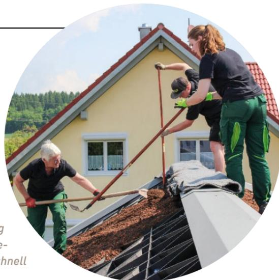
Das Satteldach mit 20° sowie 30° Dachneigung bei diesem Projekt in Oberschwaben wurde mit zwei unterschiedlichen Gründachsystemen von ZinCo begrünt – mit passgenauen Maßnahmen zur Schubabtragung und zum Erosionsschutz.
