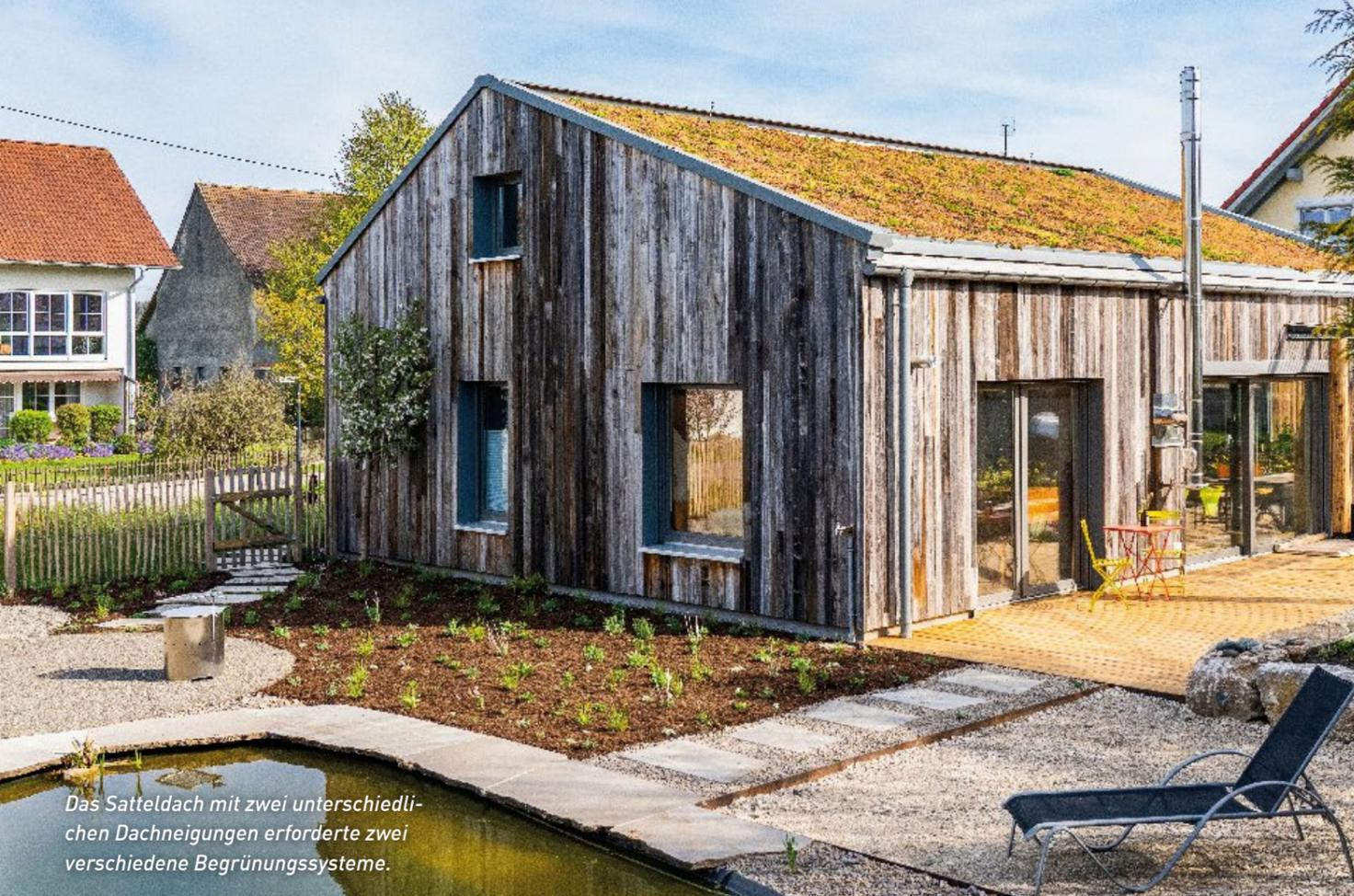
Das Satteldach mit zwei unterschiedlichen Dachneigungen erforderte zwei verschiedene Begrünungssysteme.
