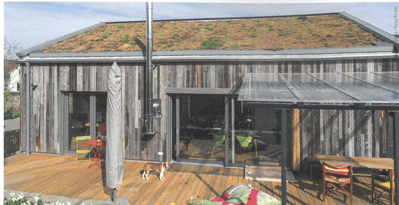
Die Rückseite des kleinen Holzhauses mit dem flacheren Dach (20° Dachneigung) trägt den Systemaufbau „Begrüntes Schrägdach“.
