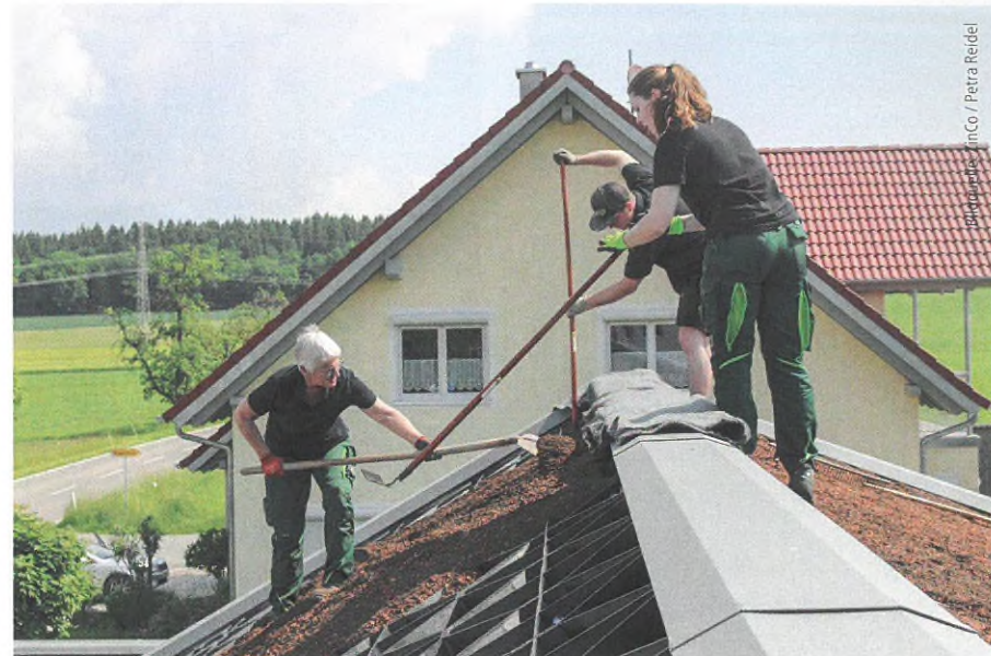
Die Systemerde „Lavendelheide-Leicht“ lässt sich nach dem Auslaufen aus dem Big Bag per Schaufel und Rechen einfach und schnell verteilen.
